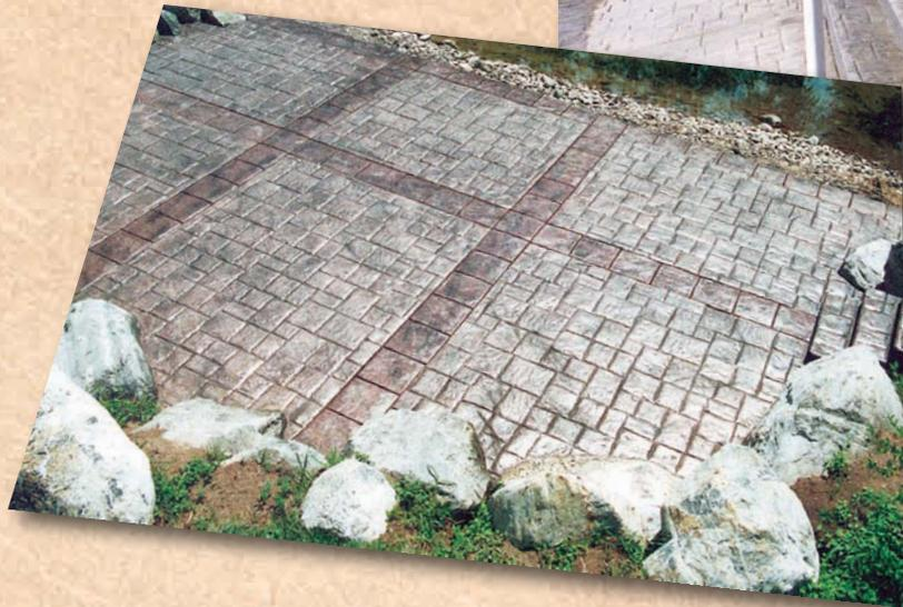
*Impresionante proyecto a orillas de un lago en el que aparecen patios, caminos y rampas para barcos. Este proyecto se creó usando el diseño pizarra de sillería con el color integral plata, el desencofrante gris marengo y ultra brillante 3000.*
