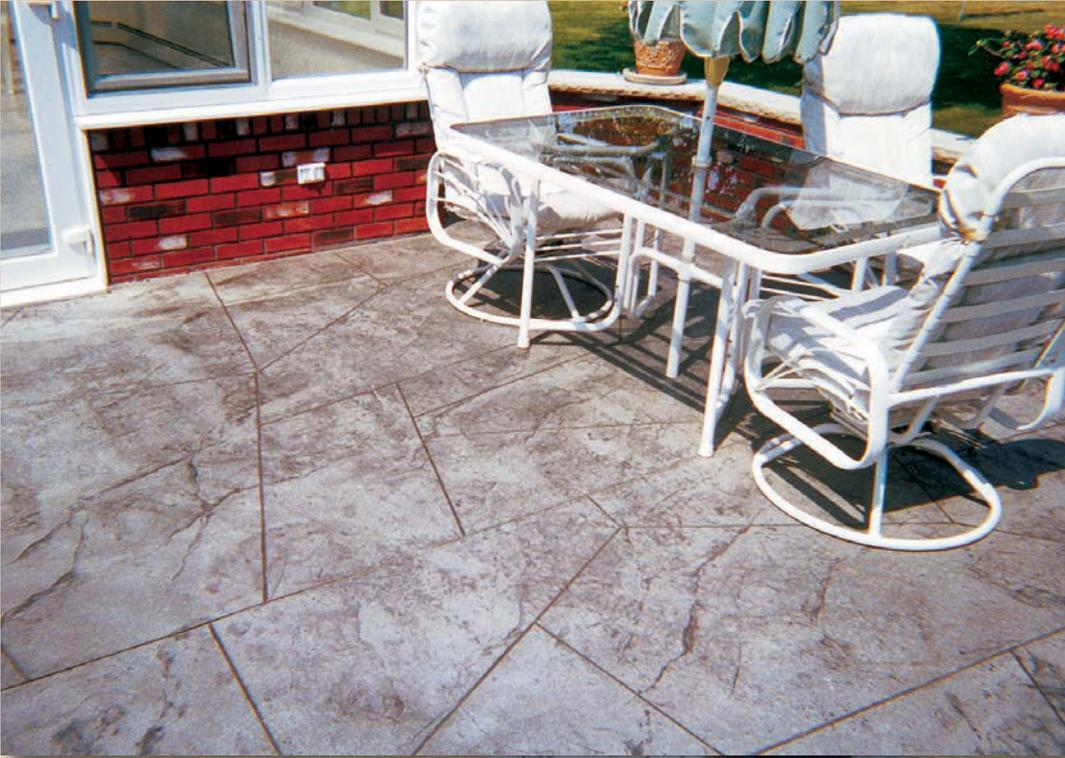
Textura de pizarra gigante utilizando el color integral plata con desencofrante gris oscuro. Cortada después con una rectificadora para simular la pizarra.
