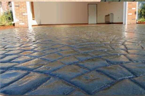
Esta magnífica entrada de garaje se terminó usando el diseño de adoquín europeo con color integral plata y desencofrante gris marengo.
