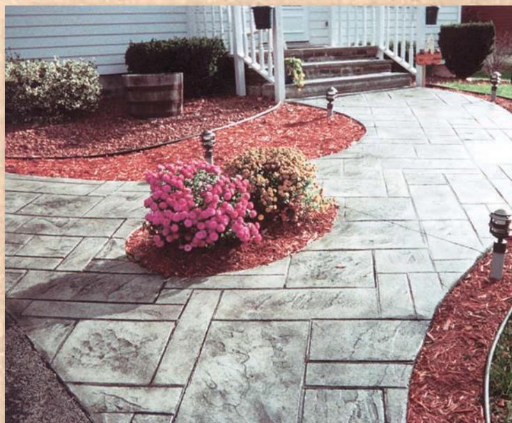
Se utilizaron color integral plata y desencofrante gris marengo con el diseño de pizarra irregular para crear esta impresionante acera.
