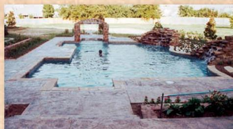
El diseño de textura de piedra gigante se cortó en rombos de 30 x 30 pulg. (76 x 76 cm) para proporcionar un aspecto arquitectónico único.
