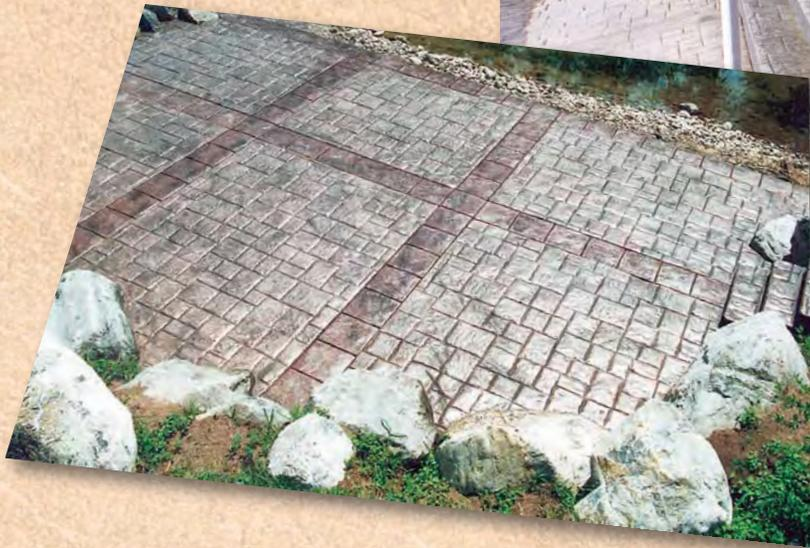
Захватывающий проект устройства набережной включает внутренние дворики, дорожки и помост для лодок. Этот проект был реализован при использовании нашего дизайна тесаного камня на бетоне серебристой окраски с применением разделительного компонента цвета древесного угля и герметика Ultra Sheen 6000.
