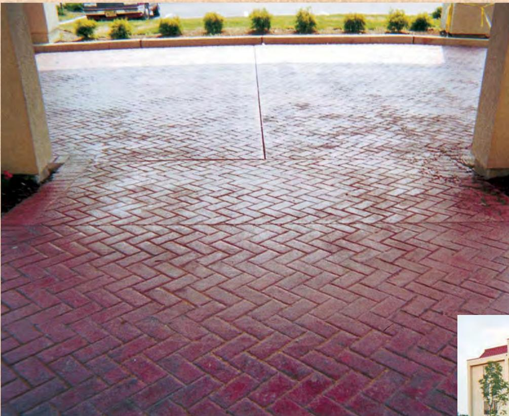
Этот вход в гостиницу "Хэмптон" (Hampton Inn) оформлен с использованием плит, изготовленных из бетона цвета ржавчины с применением разделительного темно-коричневого компонента и дизайна кирпича, выложенного "елочкой".
