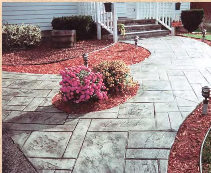
Бетон серебристой окраски и разделительный компонент цвета древесного угля использованы в сочетании с дизайном шиферной плиткой различной ширины.
