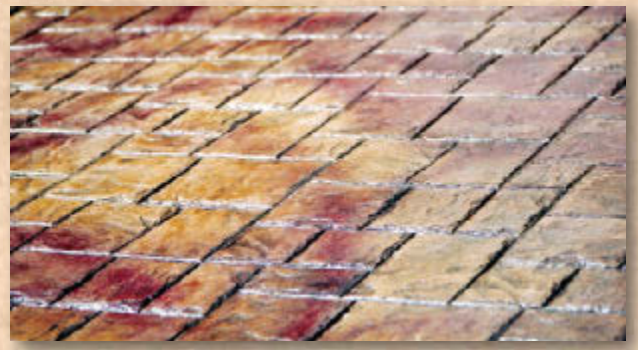
採用砂岩色整體顏料的方石板，並用磚紅色醒目顏料增量。
