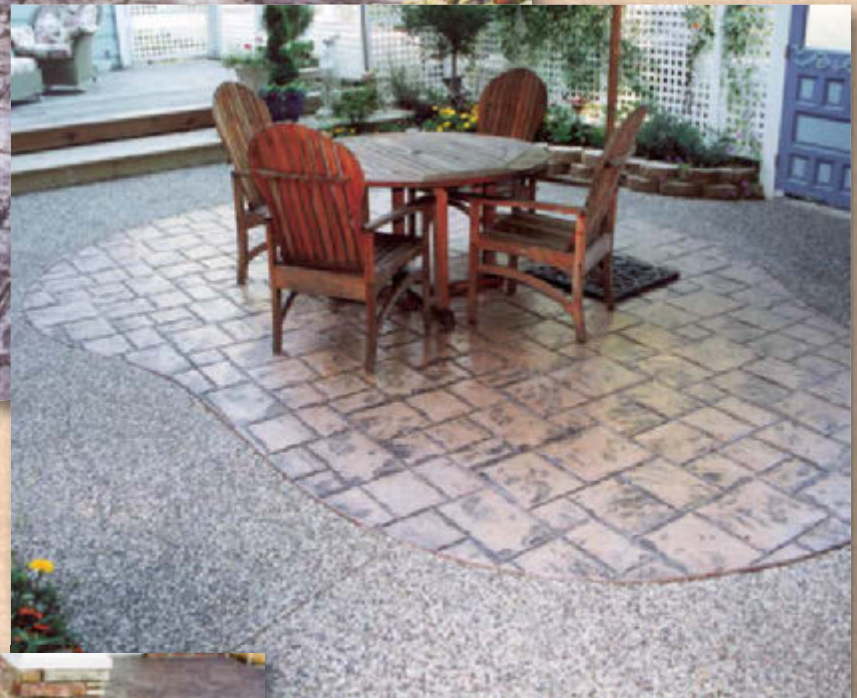
採用鋪路石整體顏料和木炭色脫模劑的方石板。
