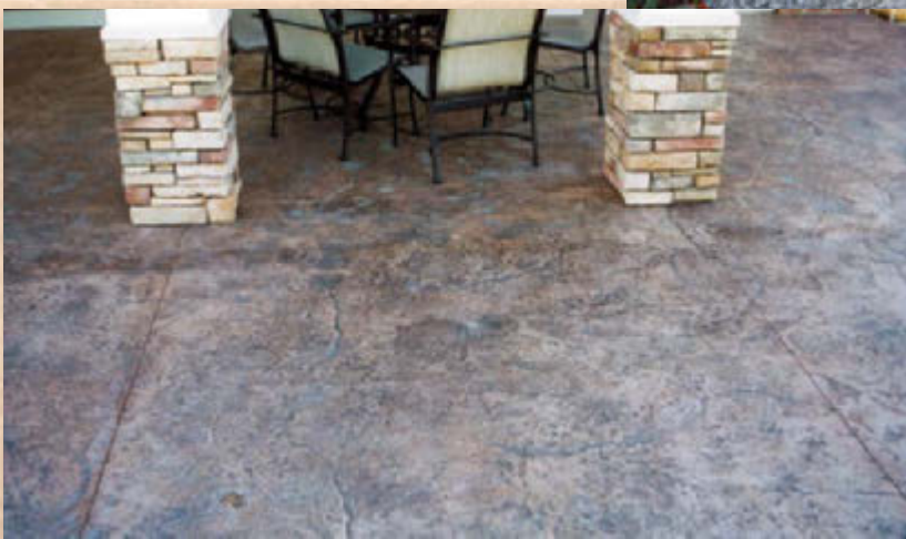
採用砂岩色整體顏料和深棕脫模劑的石料結構。
