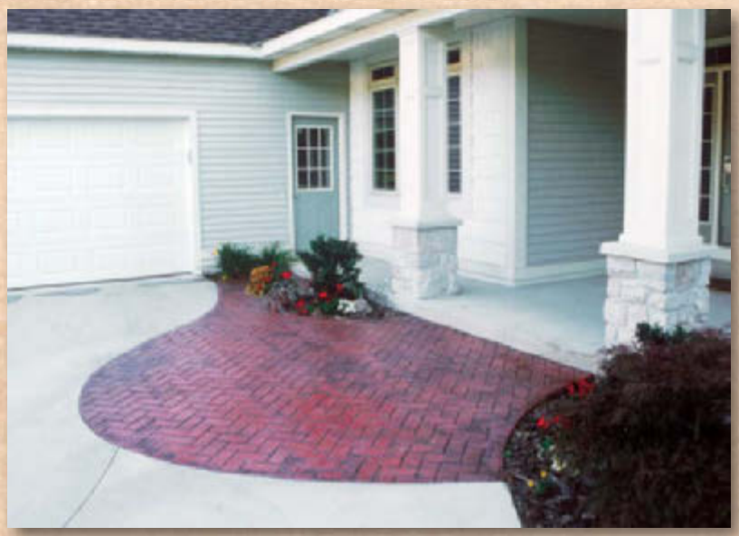
採用磚紅色整體顏料和木炭色脫模劑的魚骨形磚塊。
