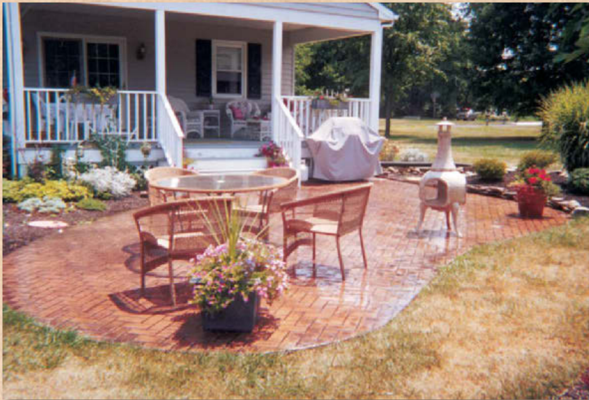
銹色整體顏料結合 深棕脫模劑，採用 魚骨形磚塊。
