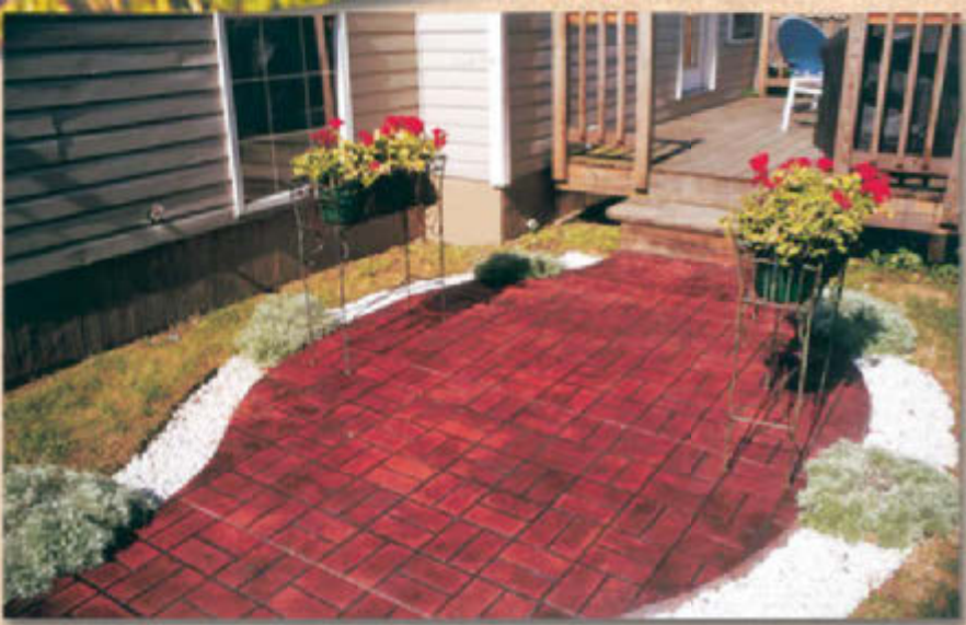
這條美觀的人行道，其樣式為編籃式格子磚塊，採用磚紅色整體顏料與木炭色脫模劑。
