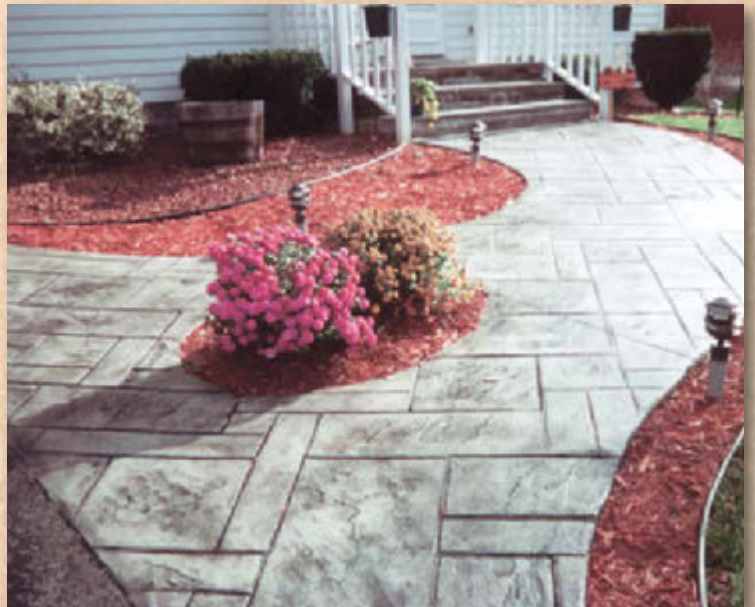
不規則的石板設計，採用了銀色整體顏料和木炭色脫模劑，從而造就了這種令人震撼的人行道。
