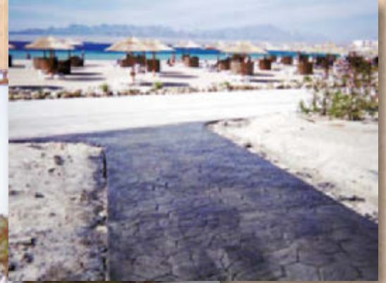
採用深灰色整體顏料和木炭色脫模劑的加州卵石。
