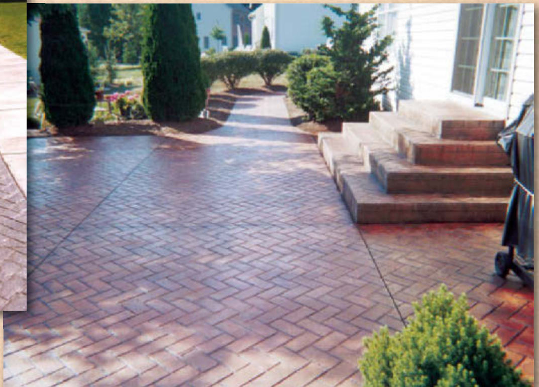
銹色整體顏料結合深棕脫模劑，採用魚骨形磚塊設計。
